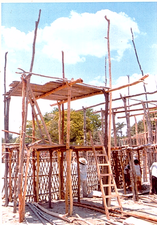
Figura 2. Estructura de horcones, similares a la vivienda maya, en la construcción de tabladros para la corrida de toros ubicada a un costado del templo. Campeche. Aurelio Sánchez.
