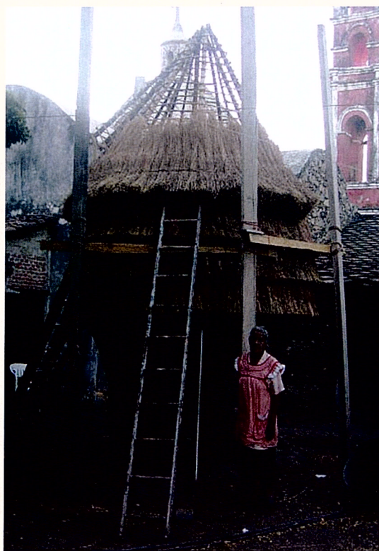
Figura 6 Rehabilitación del cuezcomato en proceso, Chalcatzingo, Mor.
