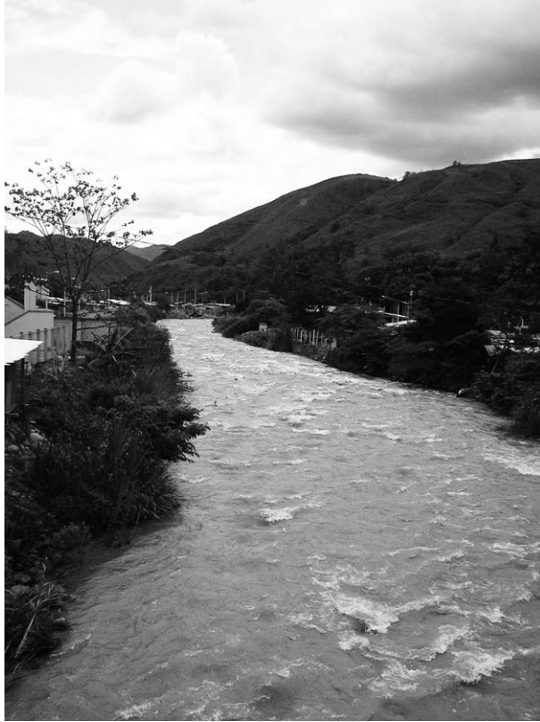
Foto 3. Asentamientos indebidos, río Portovelo. Portovelo]
