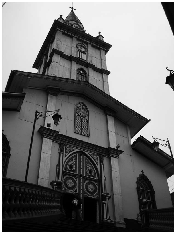
Foto 135. Fachada de la iglesia matriz de Zaruma.
