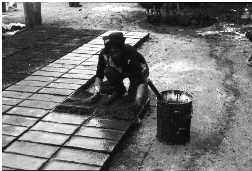
Diapositiva 4 (27) Elaboración de ladrillos, La Esperanza
