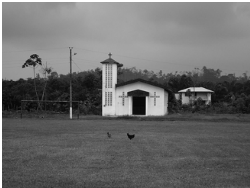
Foto 202 Fachada Iglesia Zona de Puerto Quito
