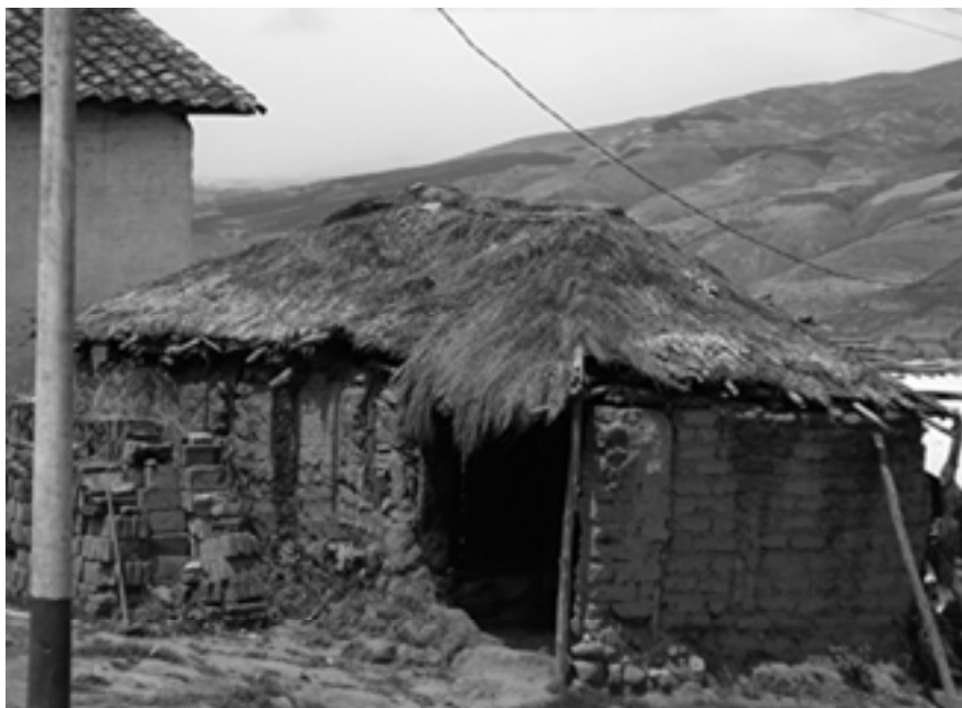
Foto 188 Construcción de Adobe Amaguaña
