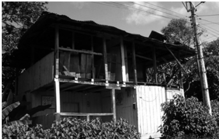
Foto 193 Vivienda Tradicional zona noroccidental
